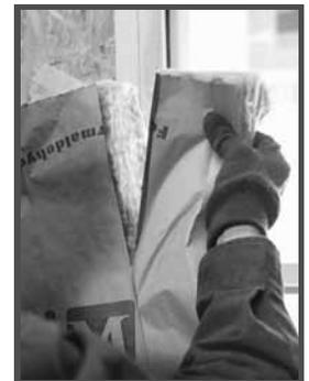
Utilice pequeños retazos de aislante para rellenar las grietas alrededor de ventanas y de puertas. Separe el aislante del revestimiento y utilice una espátula para masilla o un destornillador para meterlo en los espacios entre los montantes o en cualquier lugar a través del cual pase la luz. Este es un paso de calidad importante en cualquier trabajo.
